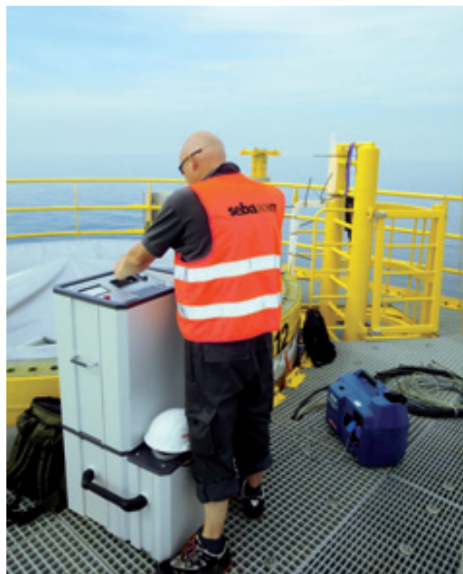
VLF CR-60 кВ во время испытаний в парке ветряных генераторов „Baltic 1“ в Балтийском море
