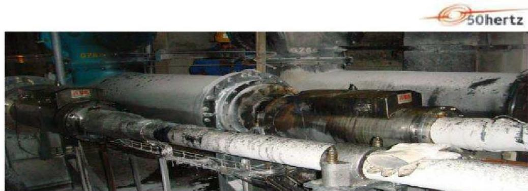
Кабель 380 кВ, год ввода 2009, пробой фазы на землю в концевой муфте КРУЭ.
