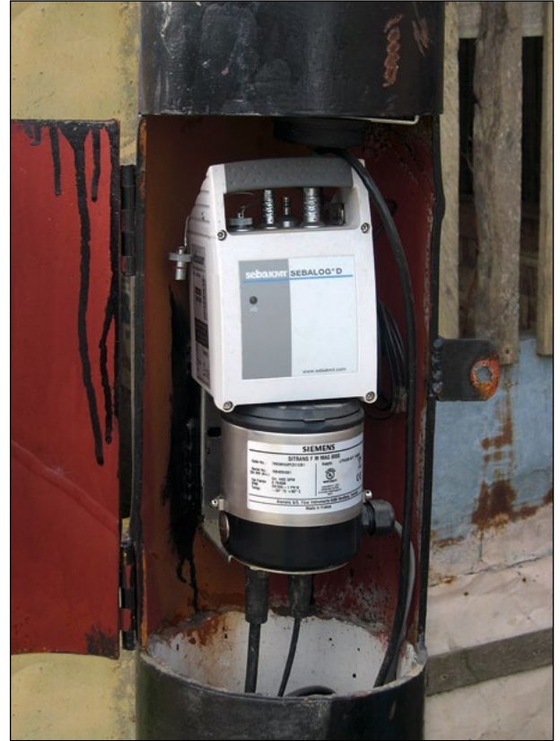
Sebalog Dx – регистратор данных, подключенный к расходомеру.
