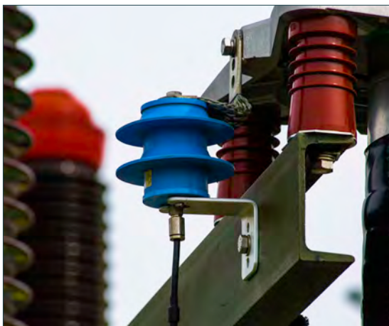
Установленный на постоянной основе УВЧ-датчик
