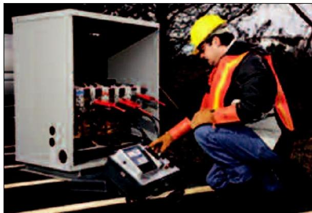
**TTR330 в процессе тестирования трехфазного трансформатора, установленного на бетонной плите**
