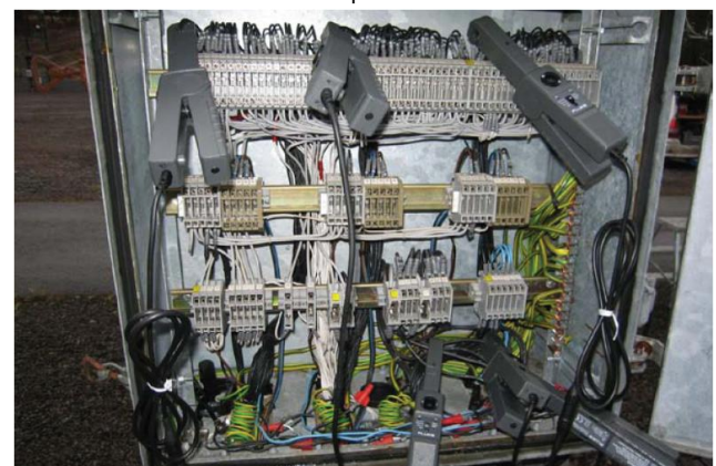
Рис. 3: Шкаф управления с токовыми клещами
