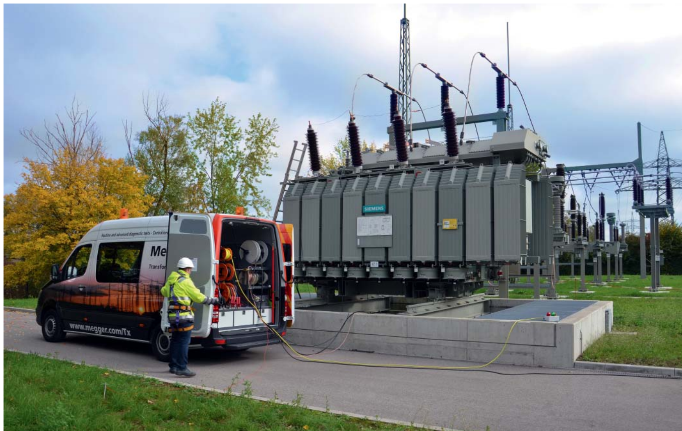
Проведение измерений параметров силового трансформатора Siemens большого габарита
